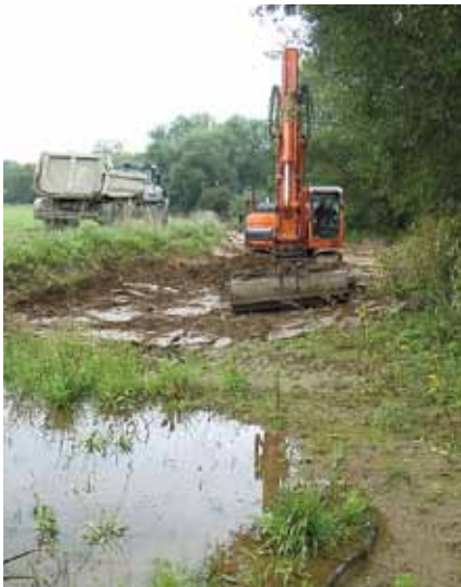
Baggerarbeiten im Abschnitt I
